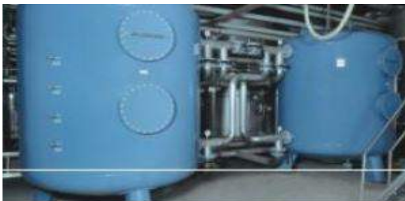
Photo: Filtre sous-pressure au charbon actif en grain (CAG)
